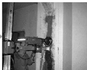
② ダイヤモンドビットによる削溝作業
