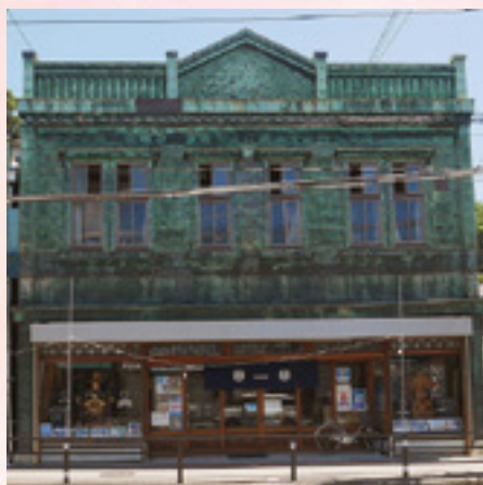
上町商店街『みどり屋』アーケード解体後の全景
