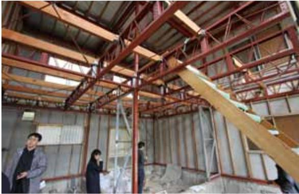
内装を撤去した状態。鉄骨の骨組みと階段がわかる\*
