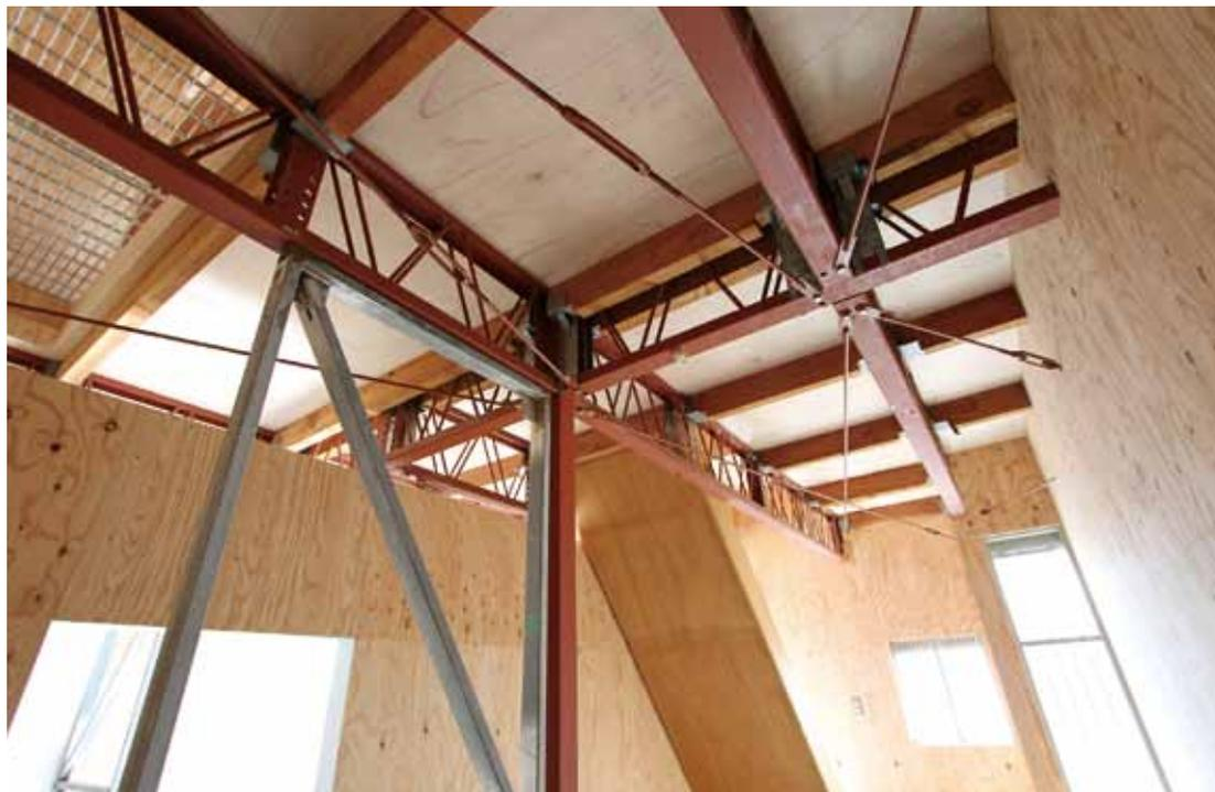
既存建物の鉄骨構造と新たに挿入した部分との対比\*
