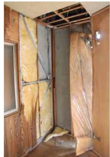
対象建物の現況。壁面内のK型の鋼製ブレースがわかる\*
