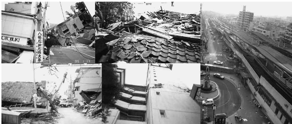
地区の被災状況
