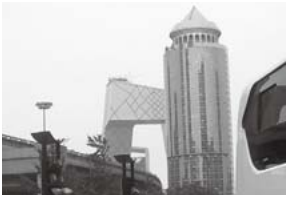
昼食のレストランの近くでオランダのOMAが設計したCCTV（中国中央電視台、高さ234m）を発見。まだ工事中のようでした。丸い塔の建築が邪魔をして全体が見えません。斜めの線も含めてストッキングのような表皮は完成しているようです。
