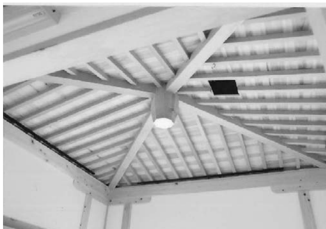
← 登り吊り束天井
