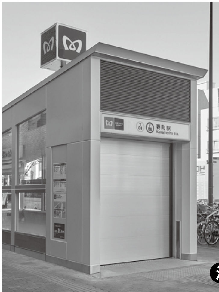
東京メトロ 要町駅設置例 (防水シャッター全閉)
