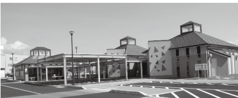
〈情報センター棟・WC棟〉
