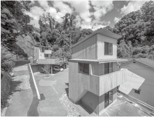
禅昌寺ガレージ A棟からC棟を見る 15)
