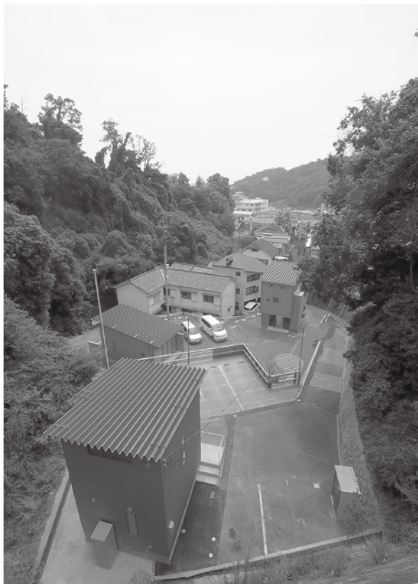
禅昌寺ガレージ 全体俯瞰写真
