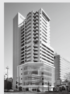
岡山市平和町1番地区 第一種市街地再開発事業 (ルミノ平和町：平成21年)
