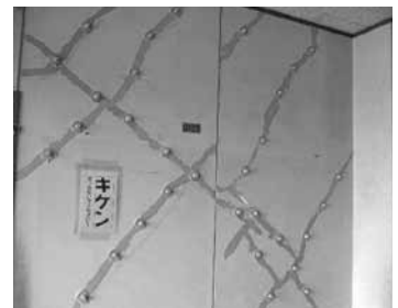
学校工事の状況
