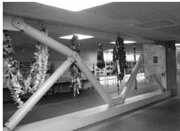
市役所の耐震補強工事
