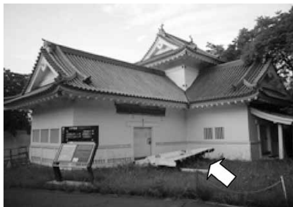
仙台城も壁が落ちていました。
